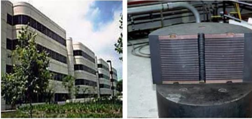
Şekil 4.14 The Foothill Communities Law and Justice Center binasının arkatarafı(solda) ve izolatör görünümü (sağda) [59]
