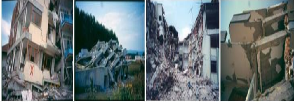
Şekil 4.3 Marmara Depremlerinde meydana gelen ağır hasar ve çökmeler [46]
