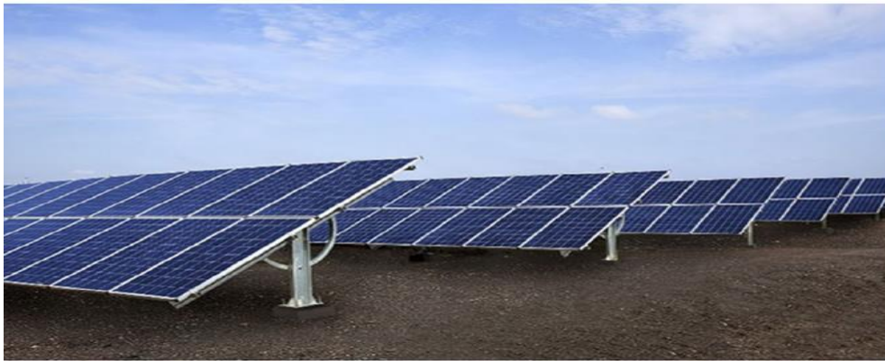
Resim 3.18 Tek eksenli yere monteli sistem
