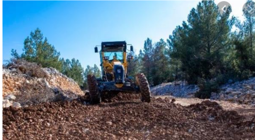
Resim 5.7 Yol yapım çalışması
