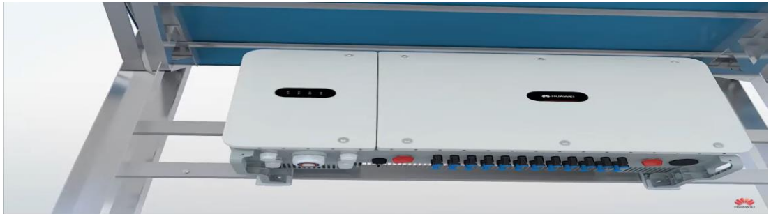
Resim 5.24 Huawei Sun 2000 60 KTL- M0 serisi dizi inverterin alttan görünümü [116]
