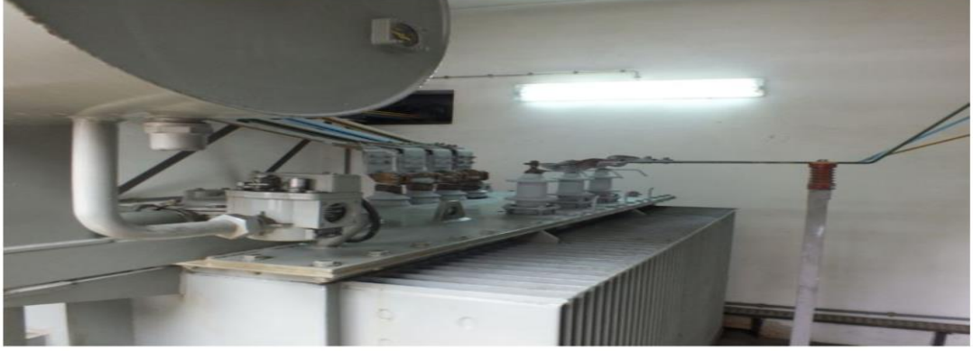
Resim 3.31 Örnek genişleme tanklı yağlı trafo [54]
