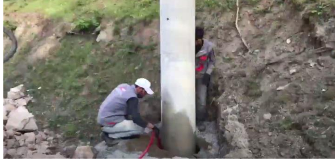
Resim 5.9 Enerji Nakil Hattı direği Dikme İşlemi [108]
