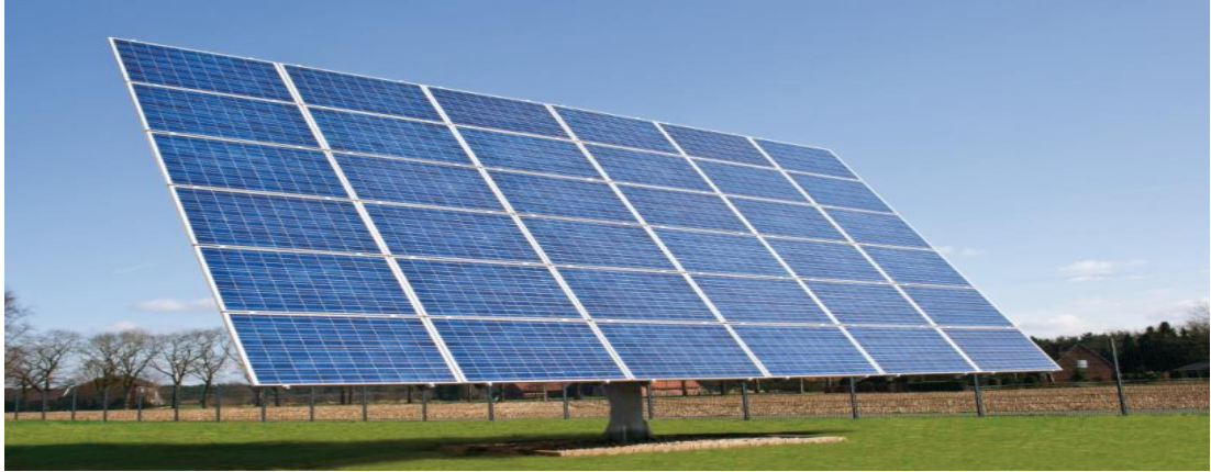
Resim 3.19 Çift eksenli güneş takip sistemi [46]
