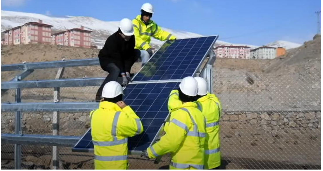
Resim 5.19 Panel montajının özenle yapılması gerektiği ile ilgili örnek resim [114]
