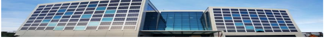
Resim 2.5 Binaya entegre fotovoltaik güneş enerjisi sistemi 110 KW [26]
