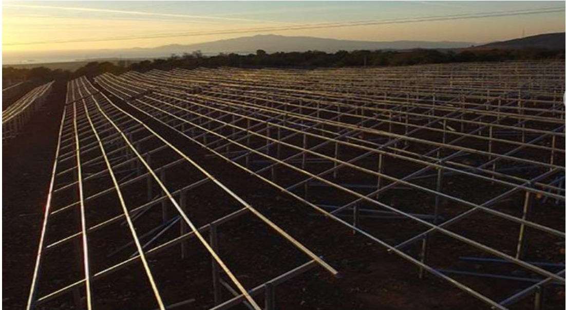
Resim 3.17 Yere monte sabit açılı konstrüksiyon sistemi [45]
