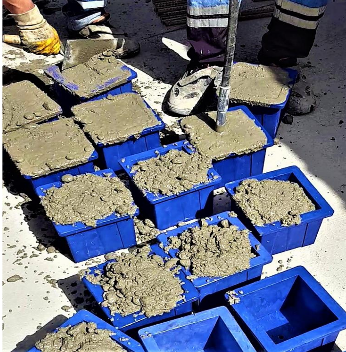
Resim 4.2 Kalıplara dökülen betona vibrasyon işleminin uygulanması
