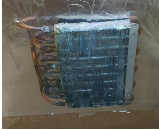
Şekil 3.5 Özel olarak imal edilmiş Evaporatöre ait görsel
