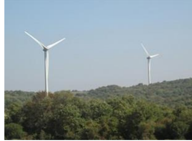
Resim 2.17 Karaburun Rüzgâr Enerji Santrali
