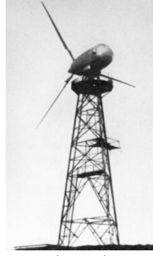
Resim 2.12 John Brown Company'nin Orkneys'deki rüzgâr türbini [13] (rotor çapı 15 m, nominal güç 100 kW)
