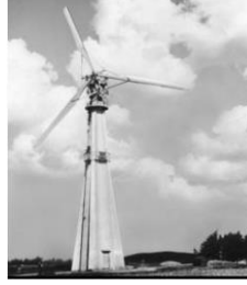
Resim 2.8 Smidth üç kanatlı rotorlu aermotor [12] (rotor çapı 24 m, nominal güç yaklaşık 70 kW)
