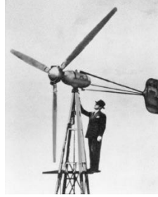
Resim 2.13 Jacobs "rüzgâr şarj cihazı" [12-13] (Rotor çapı yaklaşık 4 m, nominal güç 1,8 ile 3 kW)
