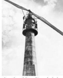
Resim 2.7 Beton kule ile Smidth aermotor [12-13] (rotor çapı 17,5 m, nominal güç yaklaşık 50 kW)
