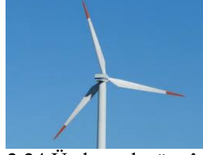
Resim 2.24 Üç kanatlı rüzgâr türbini
