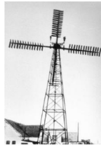
Resim 2.6 La Cour - Danimarka'da Lykkegard rüzgâr türbini [12] (Rotor çapı 18 m, yaklaşık 12 m/s rüzgâr hızında 30 kW güç çıkışı)
