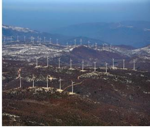
Resim 2.16 Soma Rüzgâr Enerji Santrali
