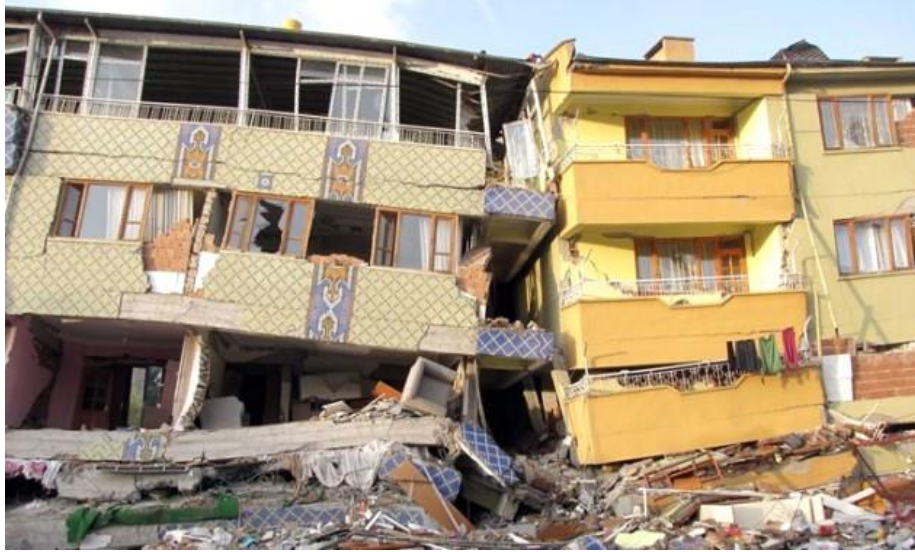
Resim 1.4 Depremde birbirlerine çarparak hasar veren bitişik nizam binalar[4]
