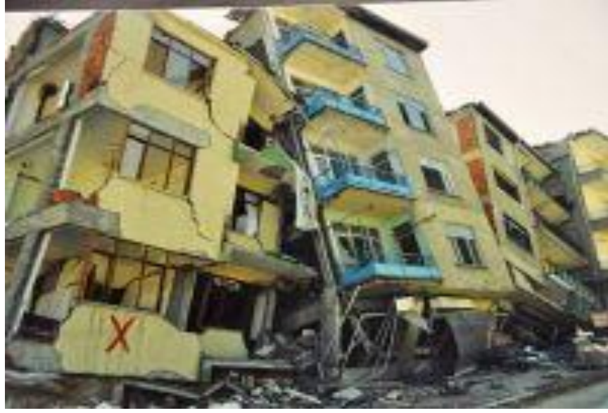
Resim 1.3 17 Ağustos Kocaeli depreminde hasar gören binalar[3]
