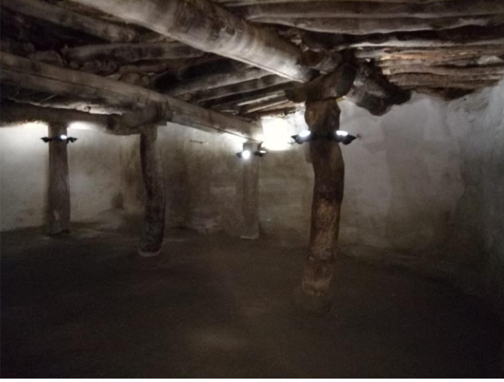
Resim 5) Küçük Ocak (Şeyh Bahşiş) Zaviyesi İç mekan
