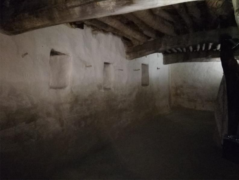
Resim 6) Küçük Ocak (Şeyh Bahşiş) Zaviyesi çevre koridoru
