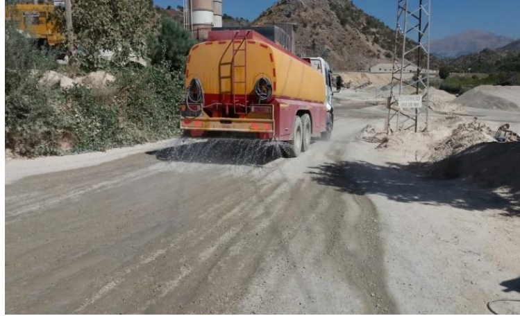
Resim 4.10 Firma05 tesis içi yolları ve tesis alanın sulanması görüntüsü
