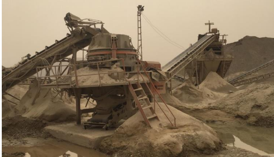
Resim 4.21 Firma10 konkasör tesisi görüntüsü
