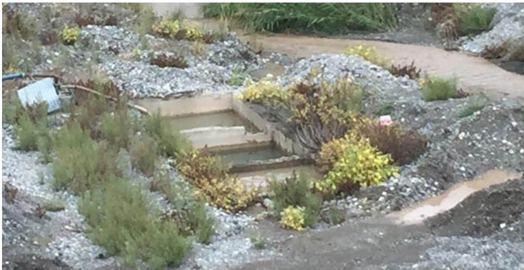
Resim 4.24 Firma 11 çöktürme havuzu
