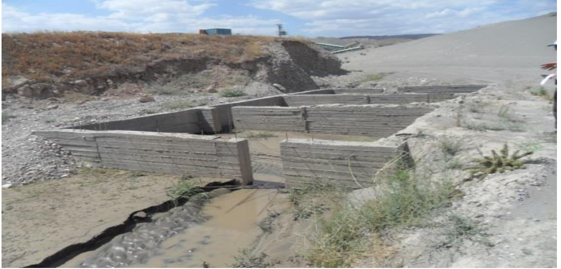
Resim 4.3 Firma02 çökeltim havuzu görüntüsü
