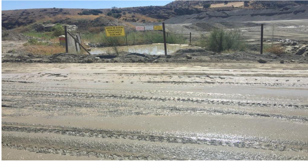
Resim 4.12 Firma06 çöktürme havuzu görüntüsü
