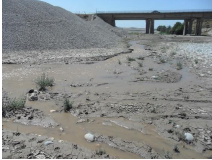
Resim 4.1 Firma01 yıkama suları görüntüsü
