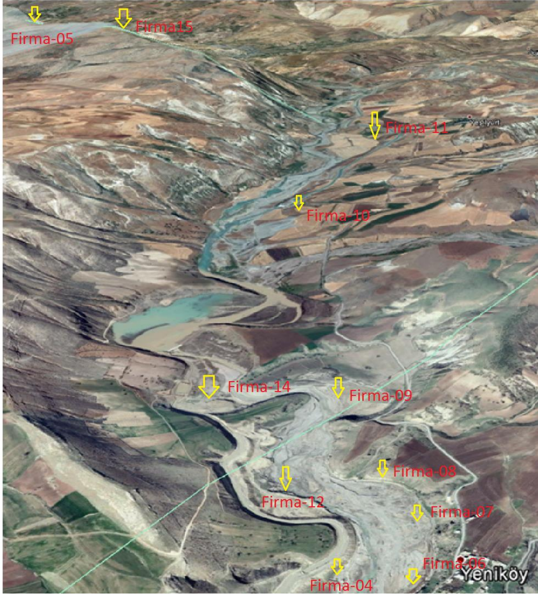
Şekil 4.1 Göksu çayı boyunca bulunan kum-çakıl kırma-eleme-yıkama tesisleri [51]
