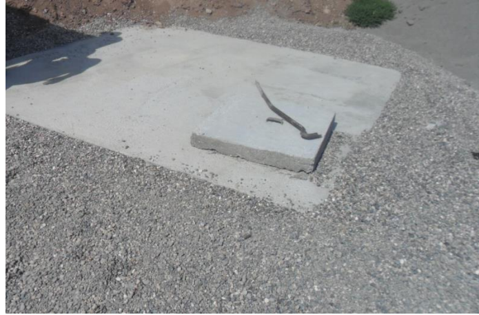
Resim 1.1 Fosseptik çukuru üst görünüşü
