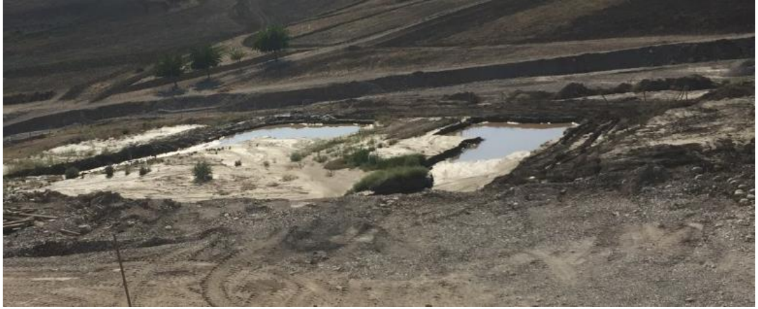
Resim 4.32 Firma13 doğal çöktürme havuzu
