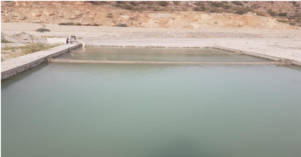
Resim 4.35 Firma15 çöktürme havuzu
