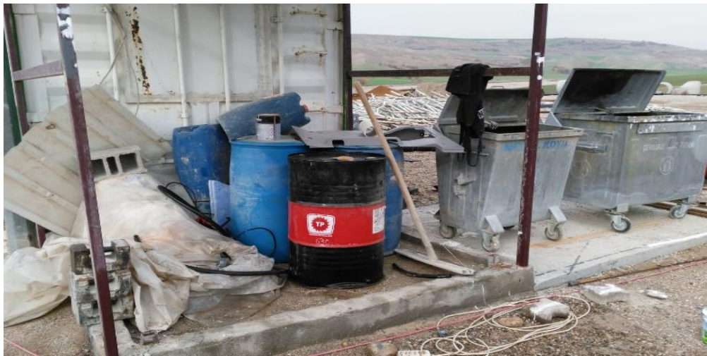
Resim 4.33 Firma13 tehlikeli atık deposu
