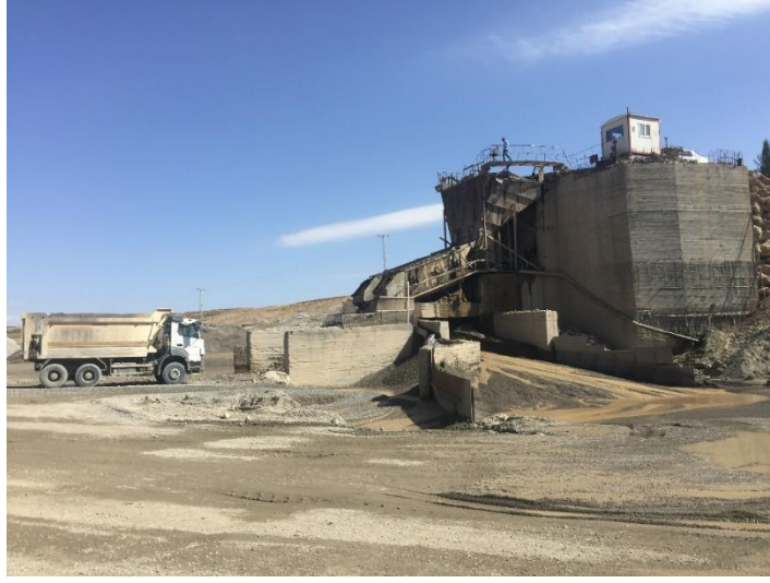
Resim 4.17 Firma08 yıkama-eleme tesisi görüntüsü
