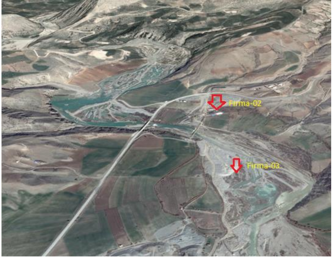
Şekil 4.2 Kâhta çayı boyunca bulunan kum-çakıl kırma-eleme-yıkama tesisleri [51]
