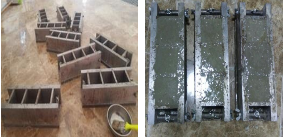
Resim 6.6 Hazırlanan Beton Karışımının Kalıplara Yerleştirilmesi
