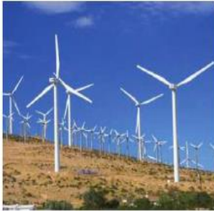
Rüzgâr enerji santrali
