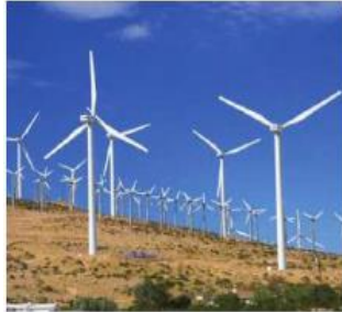
Rüzgâr enerji santrali
