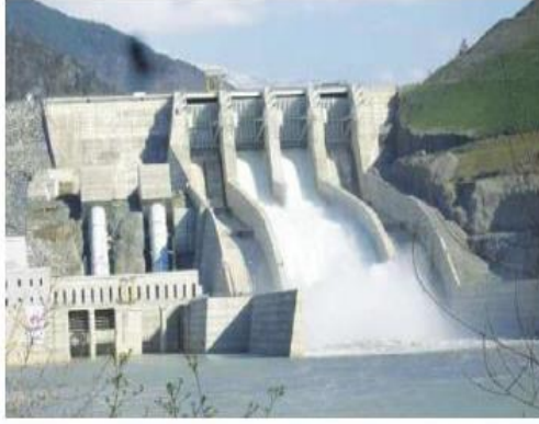
Hidroelektrik enerji santrali
