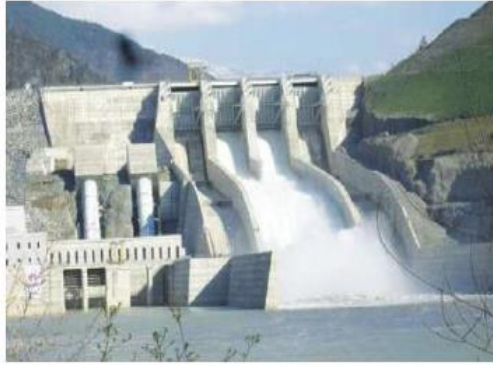
Hidroelektrik enerji santrali
