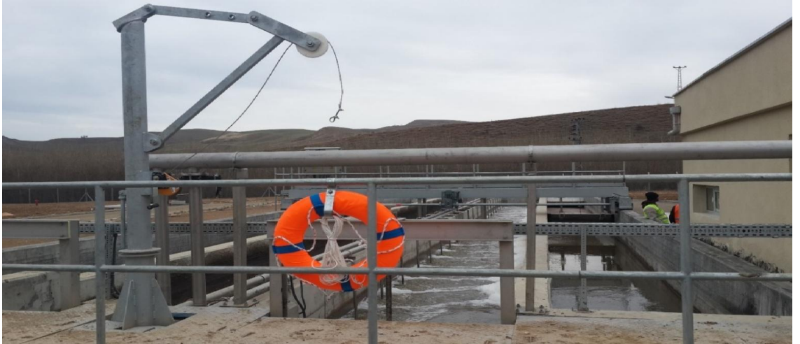
Şekil 5.5. Havalandırılmalı kum ve yağ tutucu havuz
