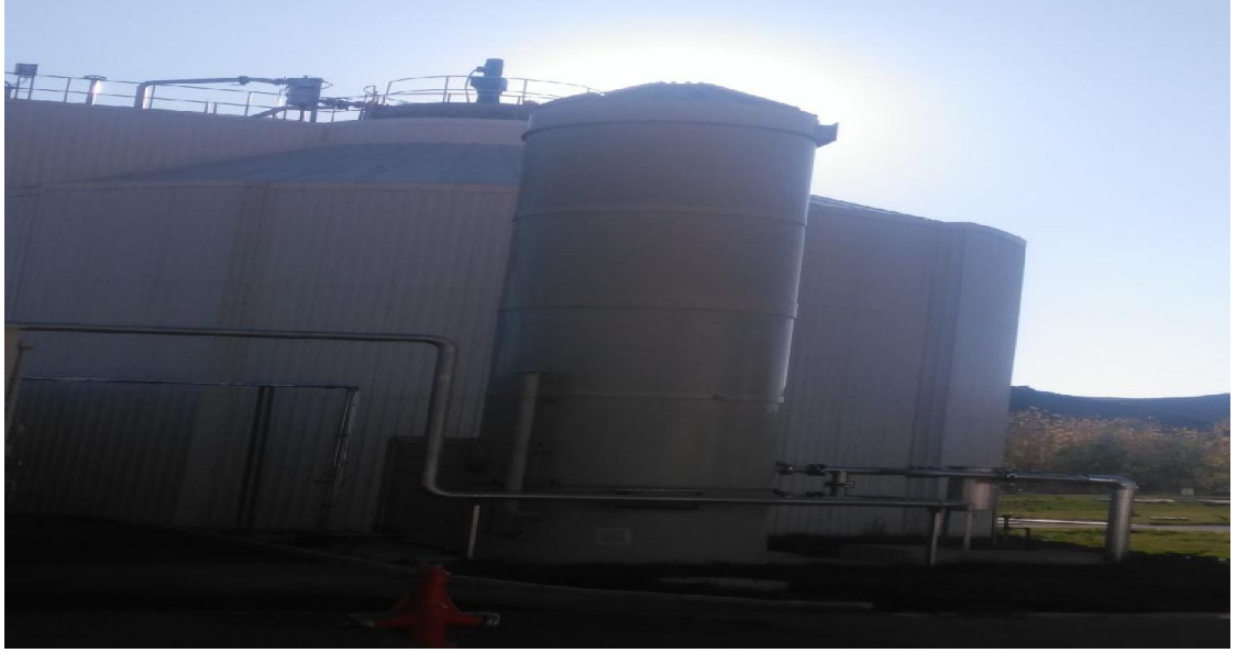
Şekil 5.10. Anaerobik çürütücü tankın dış görünümü
