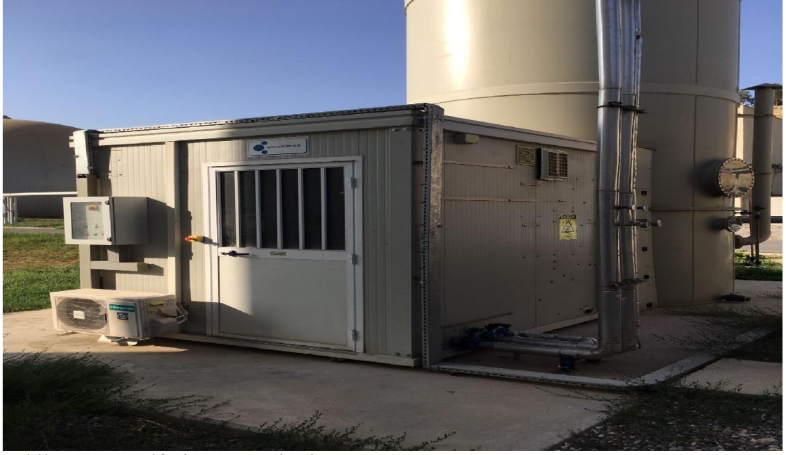
Şekil 5.11. Desülfürizasyon ünitesi
