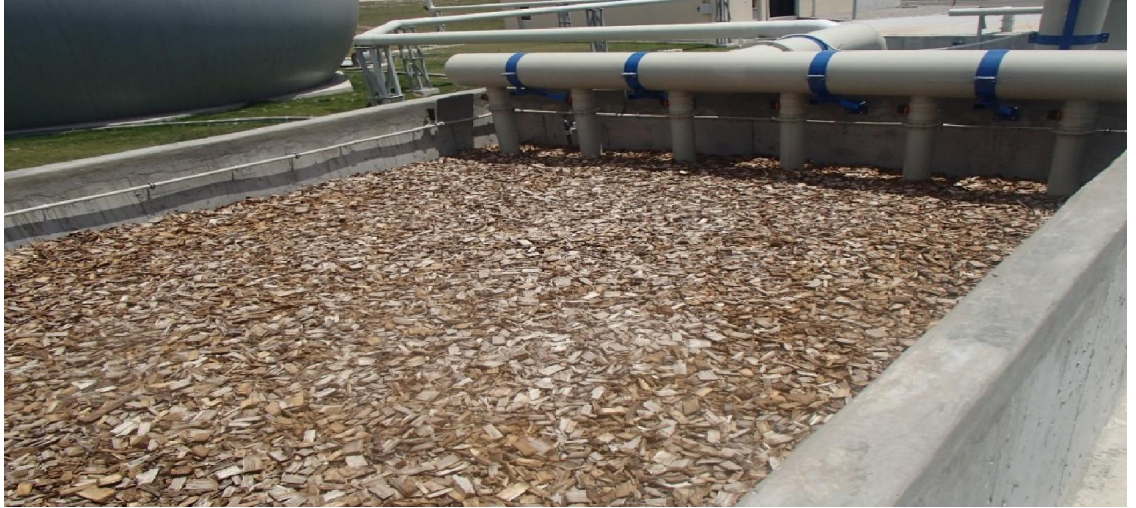
Şekil 5.13. Biyofiltre
