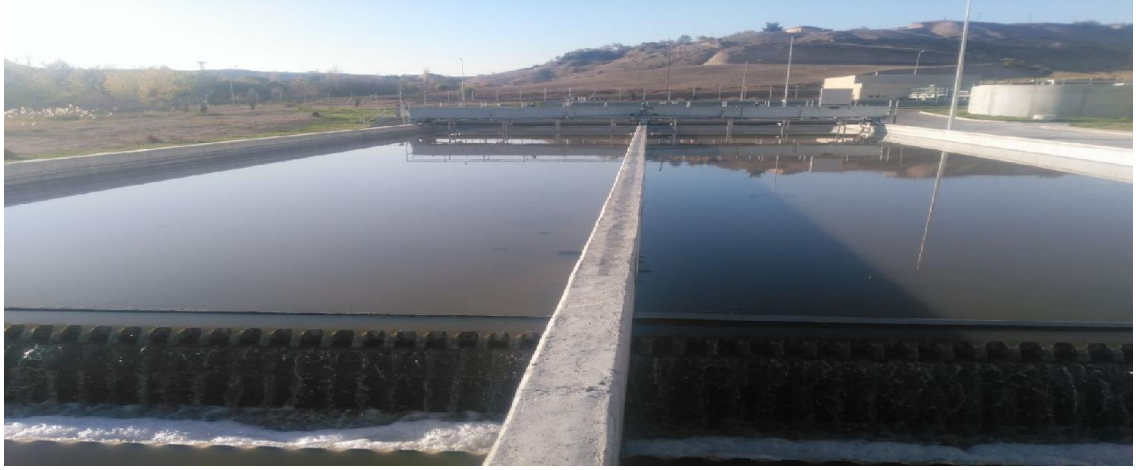
Şekil 5.6. Ön çökeltme havuzu
