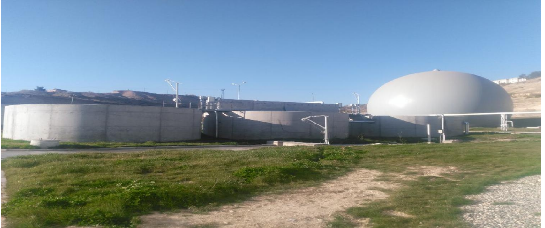
Şekil 5.16. Çamur deposu ve gaz depolama tankı
