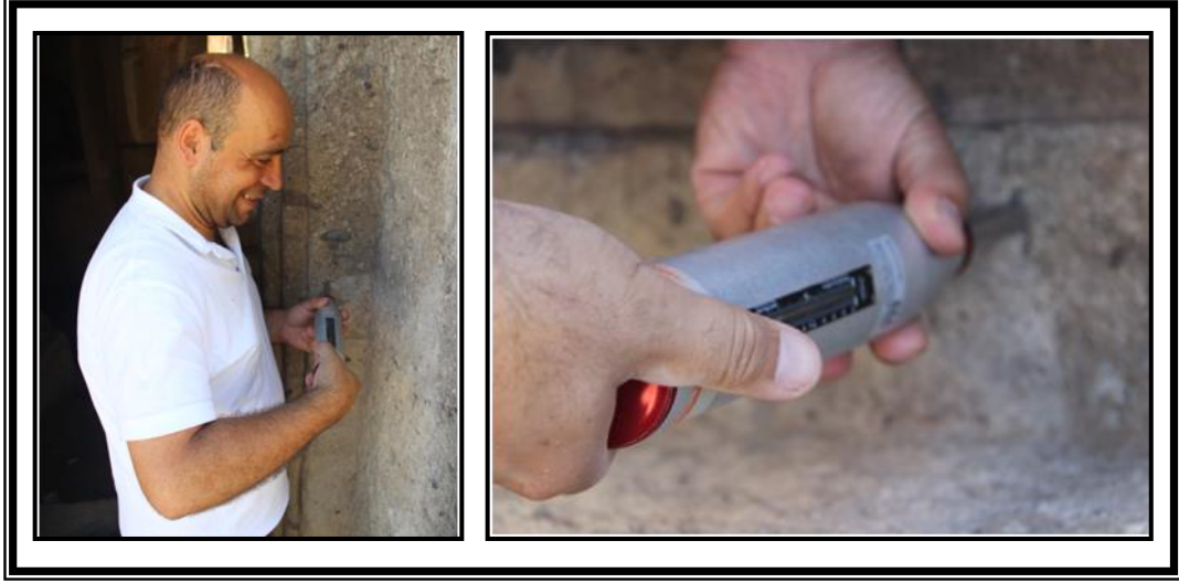
Şekil 3.2 Yapı ön duvarında Schimdt çekici sertliği ölçümü
