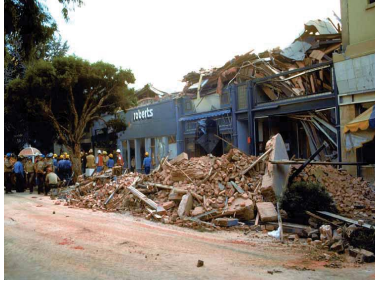
Şekil 2.2. Loma Prieta depremi sonrası görülen hasar örneği
