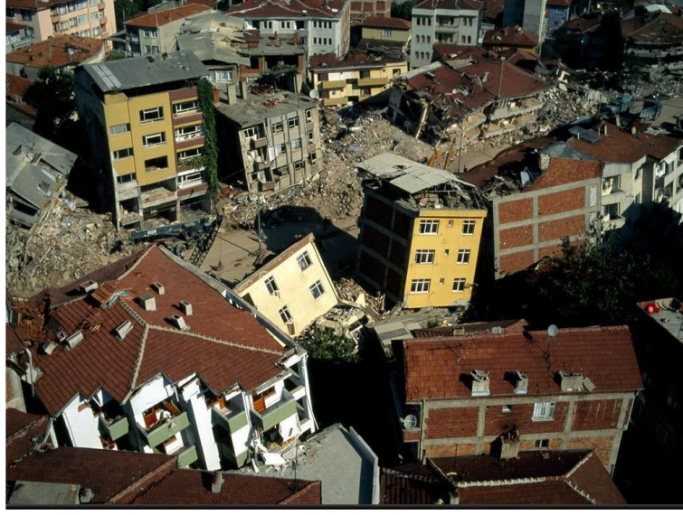
Şekil 2.5. Adapazarı ilinden çarpışma hasarlarına örnek
