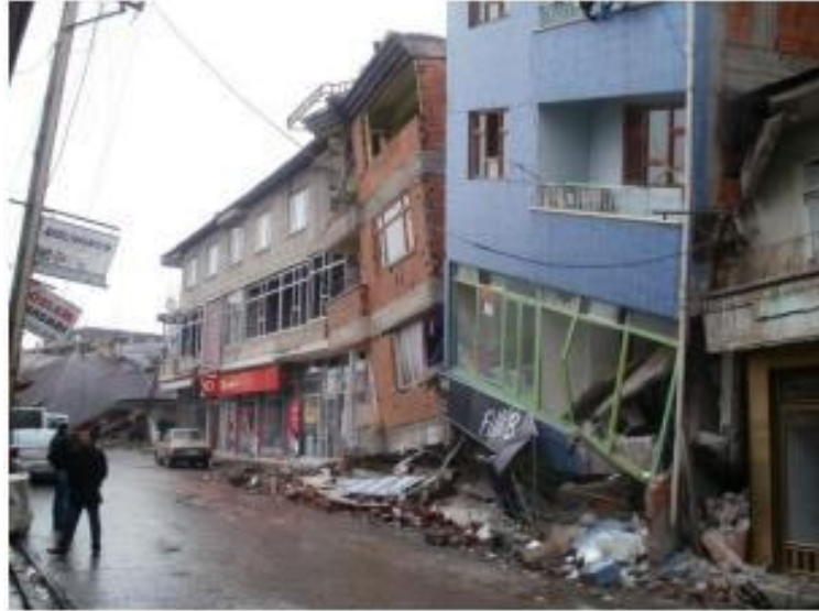
Şekil 2.6. Erciş' te çarpışma sonucu oluşan hasar (Önen vd. 2011)
