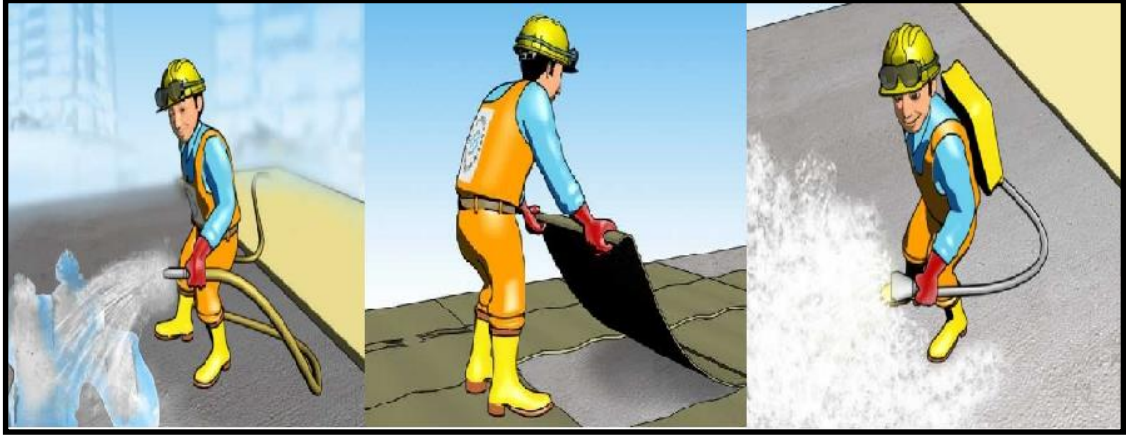
Şekil 2.5. Beton kür işlemi (THBB 2013).
