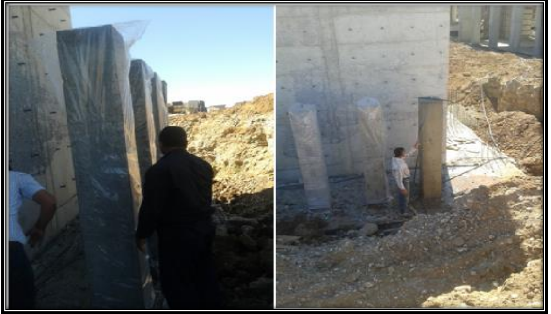
Şekil 4.5. Kolon numunelerin şantiyede kür edilmesi ve korunması
