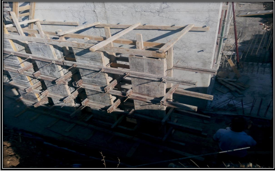
Şekil 4.1. Çalışma için kurulan kalıplar
