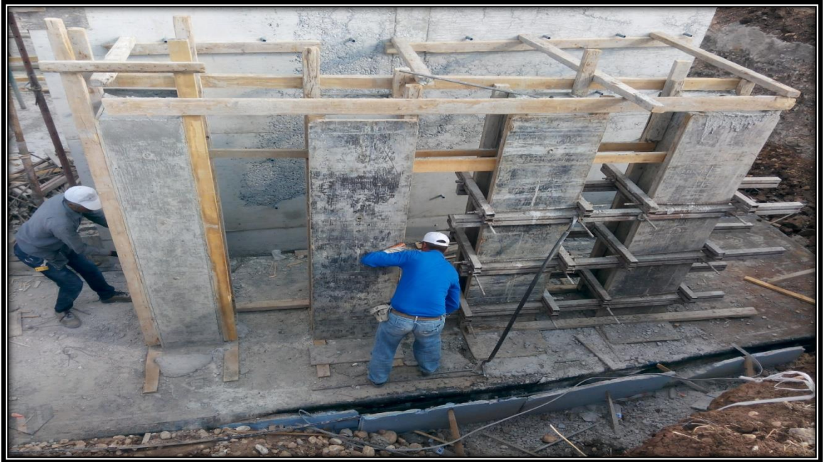
Şekil 4.4. Beton kalıplarının sökülmesi
