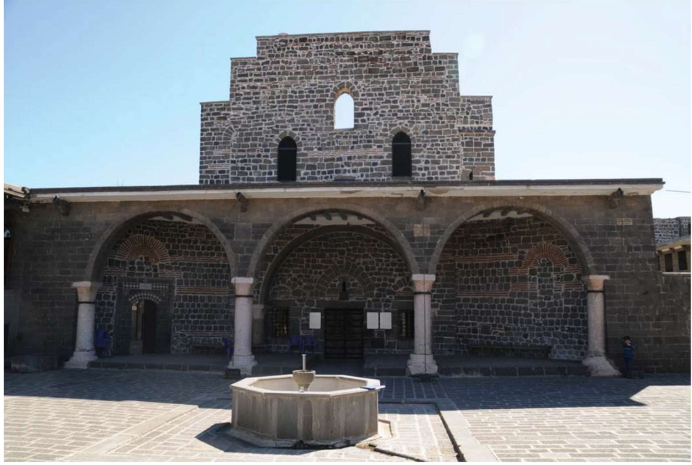
Foto 14: Meryem Ana Kilisesi 1 (Diyarbakır Kùltür Envanteri, I, s. 117.)
