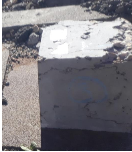
Resim 6.1 kontrol numunesi basınç deneyi sonrası oluşan hasar
