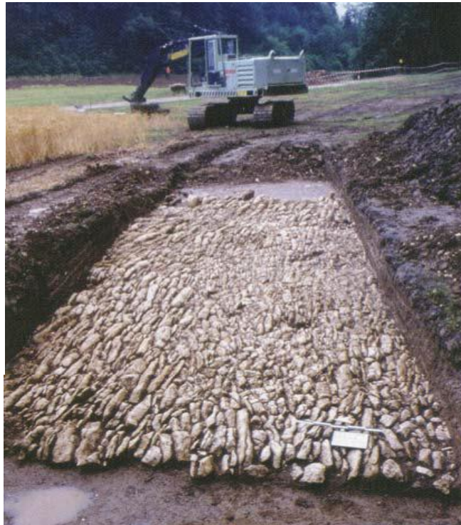
Resim 4: Dikine saplanmış taşlardan oluşan yol (En alt tabakanın kazıyla ortaya çıkarılmış)
