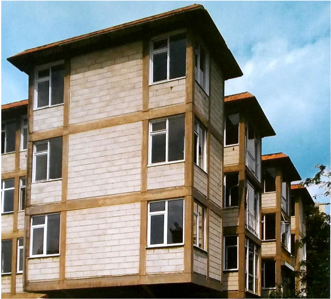
Fotoğraf 15. Çiftehavuzlar Apartmanı, Çiftehavuzlar, İstanbul, 1964-1965 (Tanyeli, Yücel, 2007: 127)
