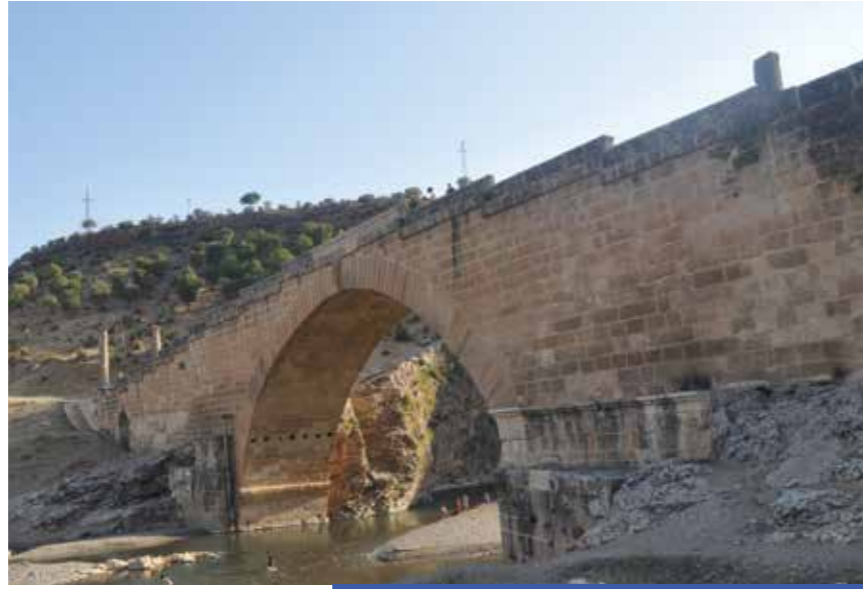
CENDERE KÖPRÜSÜ / CENDERE BRIDGE
